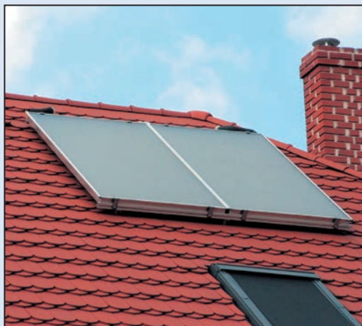
Napkollektor elhelyezése a háztetőn
